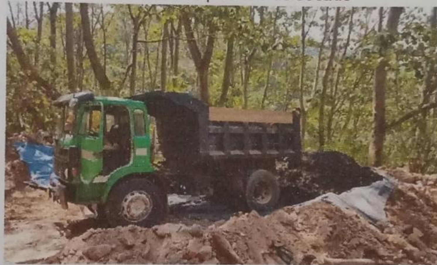
Vista de lugar de acopio de lodos
