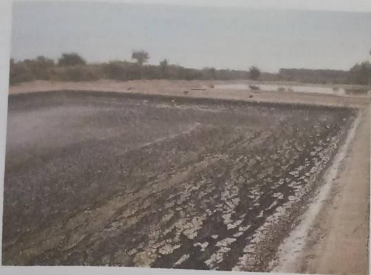
Vista de deshidratación de lodos en pileta 1
