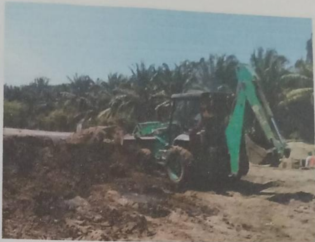
Vista de volteo de lodos para acelerar el proceso de secado
