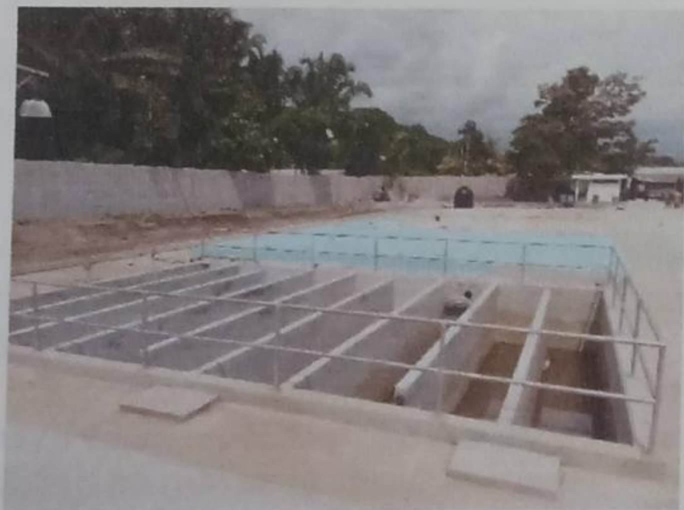
Vista de Tanques de contacto, Sedimentadores Secundarios, y FAFAS
